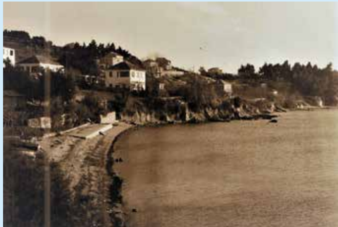
Stožanačka plaža prije izgradnje hotela Split
